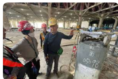
營造業 / 台積 18 廠 P9 拆除工程 (營造業輔導)
