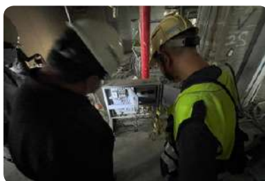
營造業 / 添鴻科技新建工程
